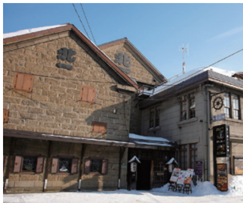
北一硝子さんの代表的な店舗である3号館は、1891年(明治24年)に建造された歴史ある木骨石張倉庫です
