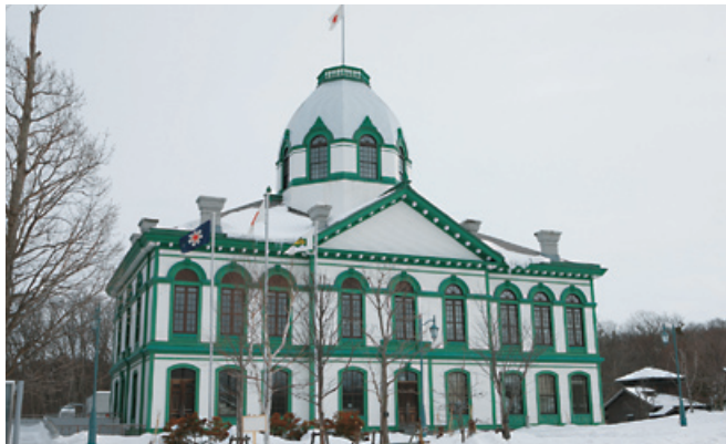
明治6年(1873)に建てられた旧開拓使札幌本庁舎。現在は、ビジターセンターとして使用されています
