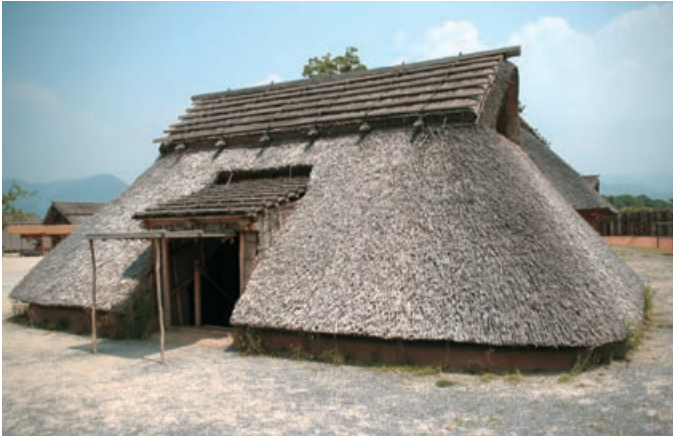
地面を掘り下げて作った半地下式「竪穴住居」。
